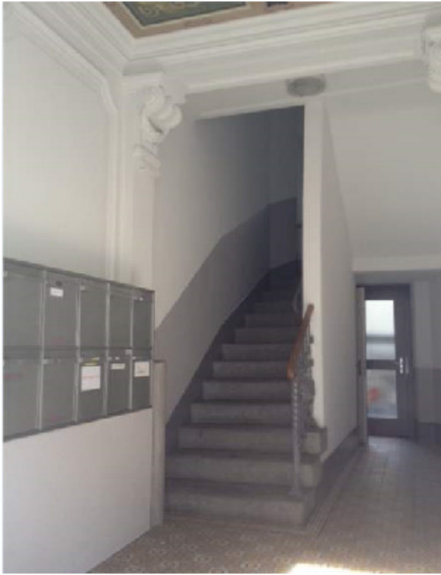
Doppelt exsives Treppenhaus. Höschgasse 33, 8008 Zürich
